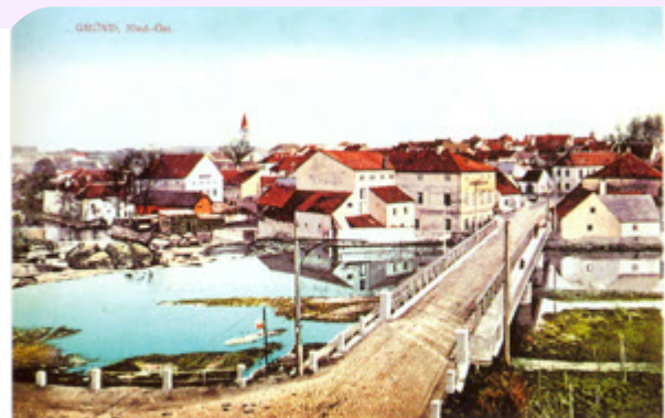
Most mezi Gmündem a Českými Velenicemi v roce 1907. Patrné jsou stožáry trolejového vedení na jeho předpolí.
