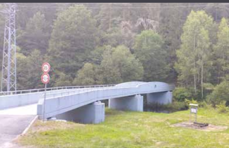
Most u vodní elektrárny
